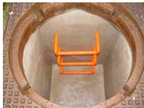
Fertig sanierter Schacht
