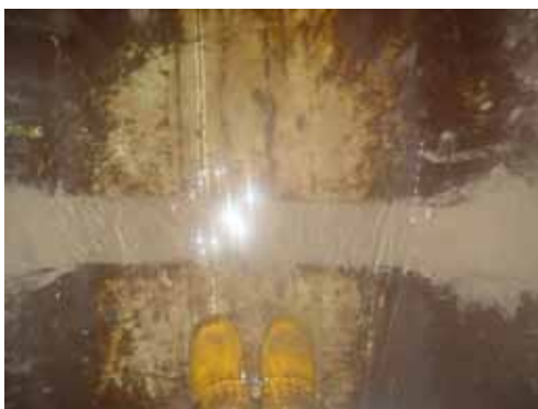
Verarbeitung des KÖSTER Schachtmörtels unter fließendem Wasser
