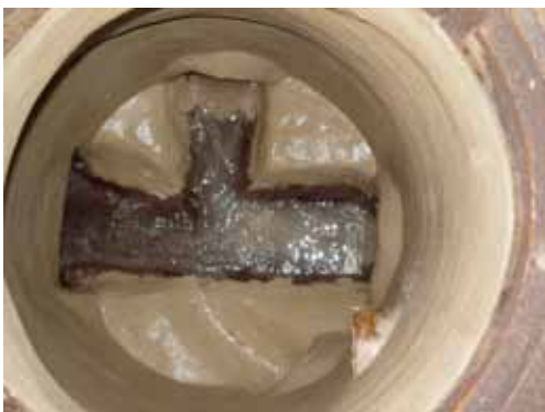
Mit KÖSTER Schachtmörtel geschützter Abwasserkanal mit zugehörigem Schacht
