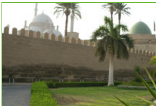
Esempio di umidità di risalita
