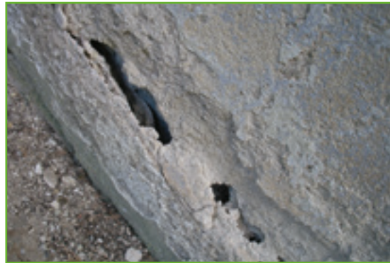
Danneggiamento dell'intonaco.
