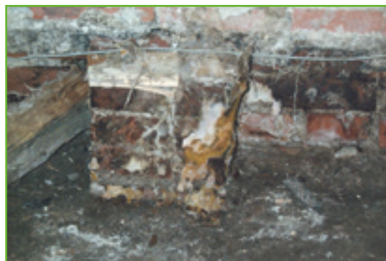
Sviluppo di muffe e danni alla struttura dell'edificio
