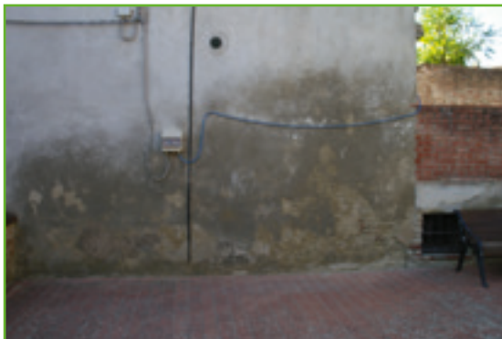
Cambiamento di colore, diminuzione dell'isolamento termico.
