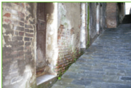
Distacco dell'intonaco e danneggiamento dei corsi di malta.
